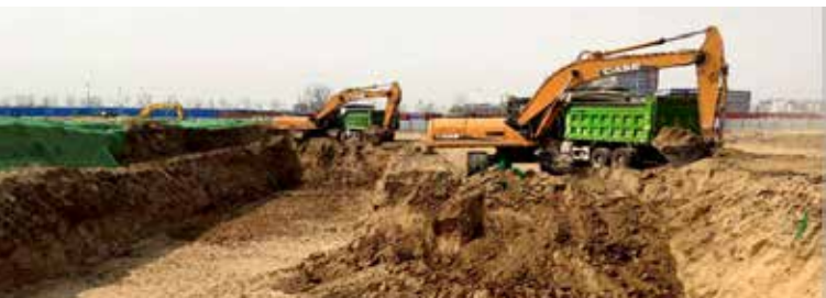
高端汽车及新能源汽车关键零部件产业园施工现场
