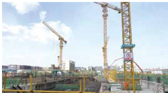
京广协同创新产业园建设现场
